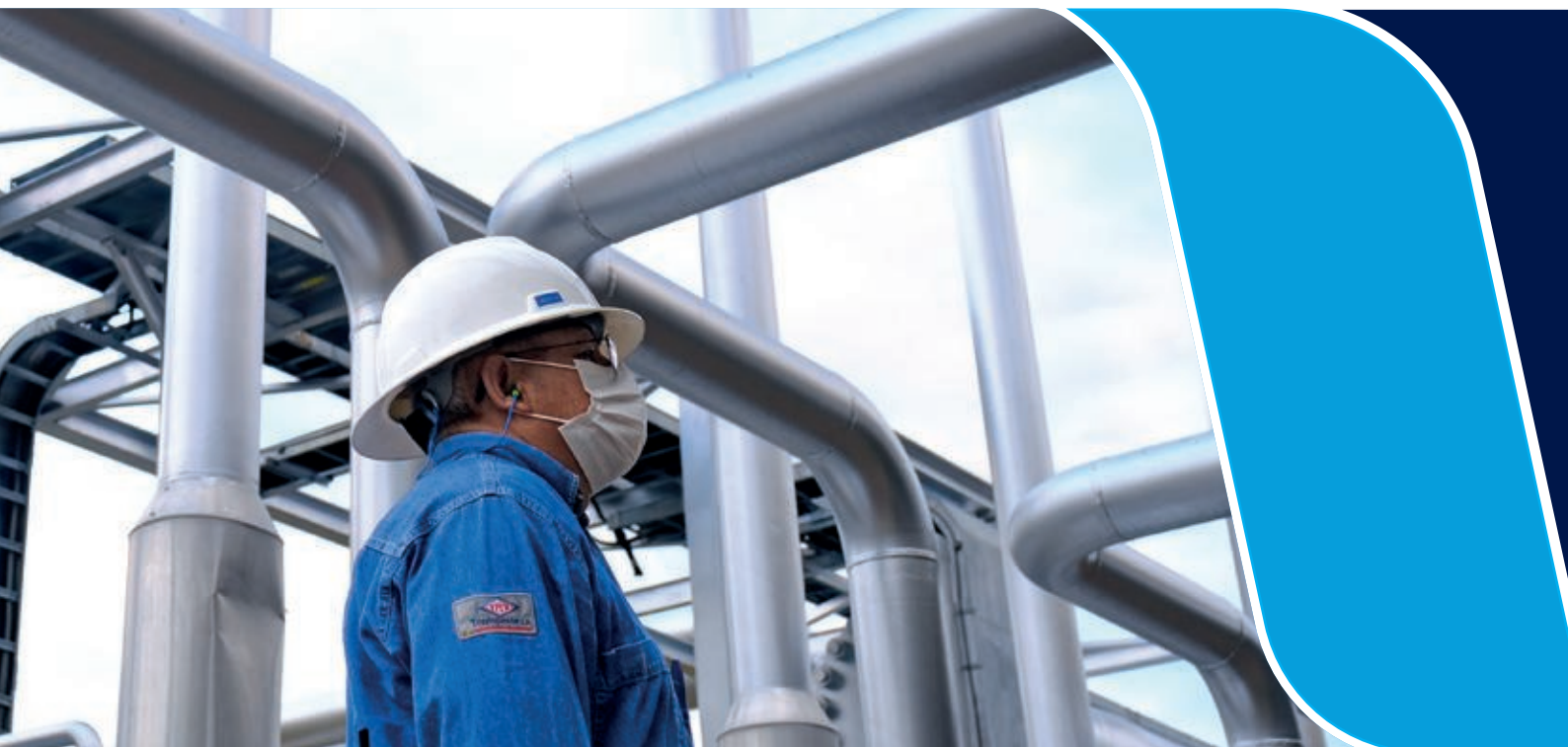
ESTACIÓN DE COMPRESIÓN VILLA MONTES (ECV)
