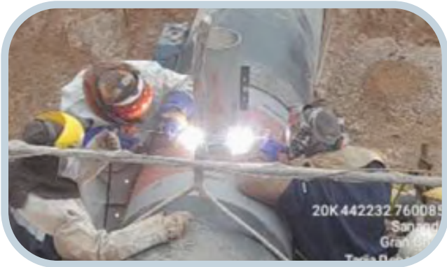
Soldadura de Niples de 8" sobre ducto de 32"
